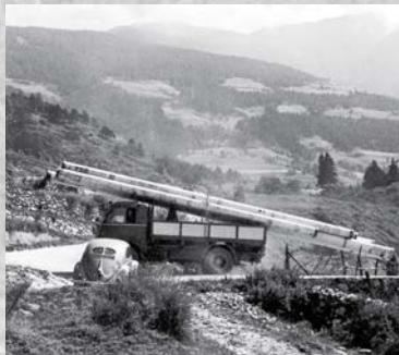
Anlieferung und Transport der Rohre. Fornitura e trasporto dei tubi. Delivery and transportation of pipes.
