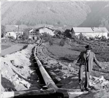
Verlegung der Rohre auf den Wiesen in Natz. Posa dei tubi sui prati di Natz. Laying down of the pipeline in the meadows of Natz.
