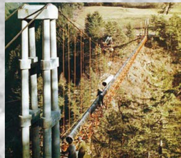
Arbeiten in luftiger Höhe - nur etwas für Schwindelfreie. Lavorare sospesi nel vuoto, una missione a prova di vertigini. Working high up in the air - not for the faint-hearted.
