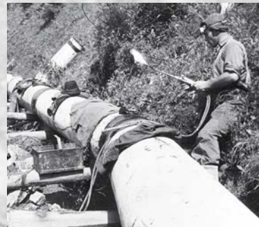
Mühsam war auch das Verschweißen der Rohre. Faticosi anche i lavori di saldatura. The welding-together of the pipes was a formidable task.
