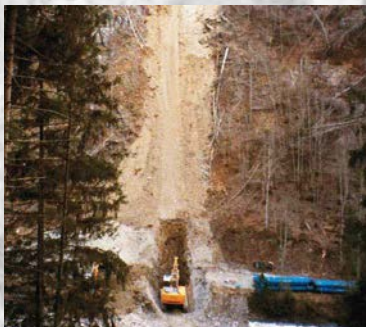
2005. Grabungsarbeiten im Steilhang. Die Leitung wird unter den Fluss verlegt. Die Bagger mussten mit Seilwinden angehängt werden. 2005. Lavori di scavo in pendenza. Posa della condotta sotto il fiume. Scavatori ancorati con l'aiuto di verricelli. 2005. Excavation work on a steep slope. The pipeline is installed beneath the river. It was necessary to fasten winches to the diggers.
